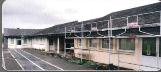
La rénovation de la toiture de l'école
