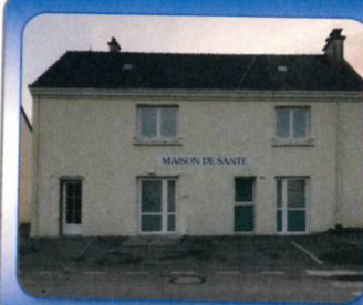
La transformation du local 13 place de l'église en Maison de Santé
